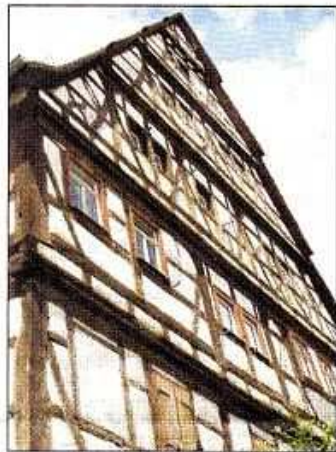
Soll saniert werden: das Schwedenhaus.
