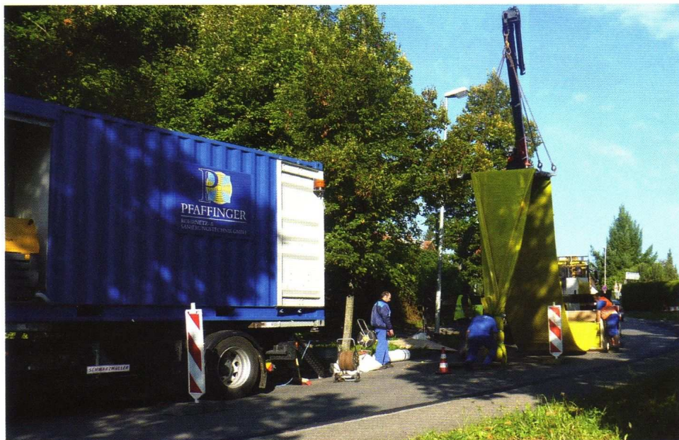
Der Einzug des Liners auf der Baustelle Justinus-Kerner-Straße in Reutlingen.
