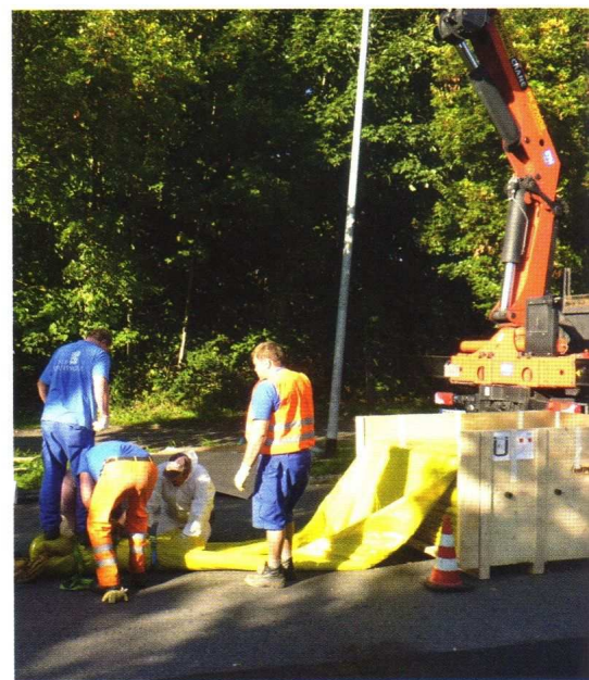
Binden des Schlauchlinerkopfes.
