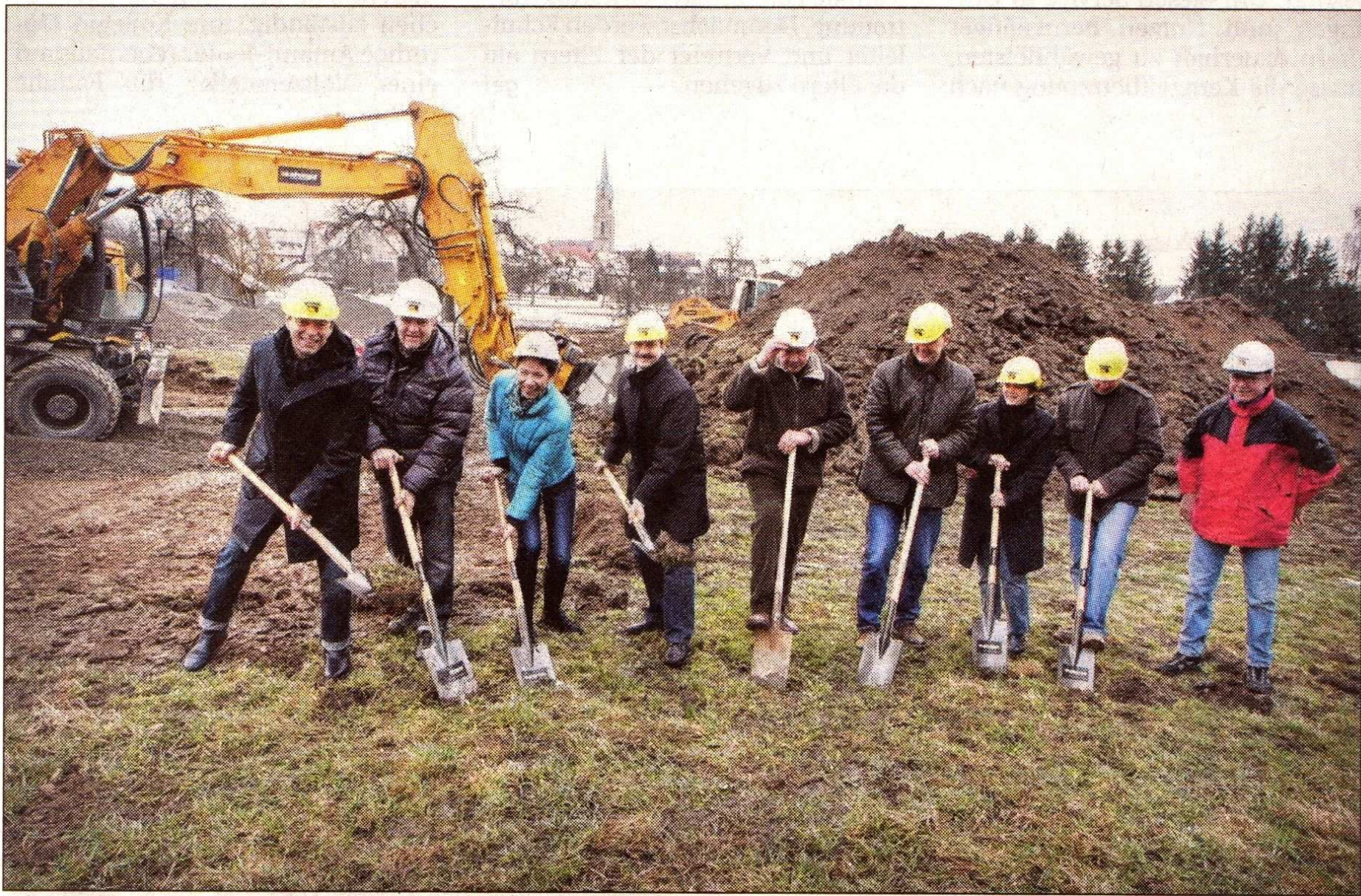
Mit funkelneuen Spaten traten gestern Planer Paul Gauss (von links), Arne Stumpff von der gleichnamigen ausführenden Tiefbaufirma, die CDU-Landtagskandidatin Lisa Federle, Bürgermeister Thomas Noé, Nachbar Josef Pfeffer sowie die Gemeinderäte Burkhard von Ow-Wachendorf, Christina Schweizer, Ralf Günther und Alois Noll an. Bild: Mozer
