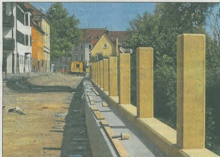
Fast fertig ist die neue Stützmauer mit Geländer.
